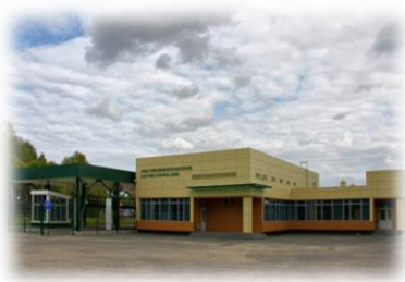
Таможенный терминал на Северной площадке ОЭЗ «Томск»
